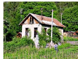
La centrale idroelettrica di Leo Baldovin Carulli
